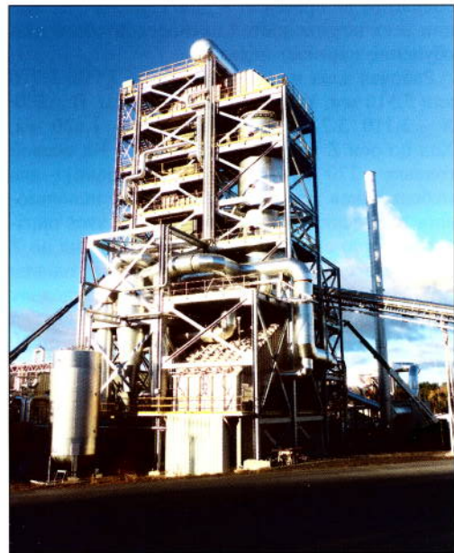
Установка мощностью 31.5 МВт в штате Мэн (США)
