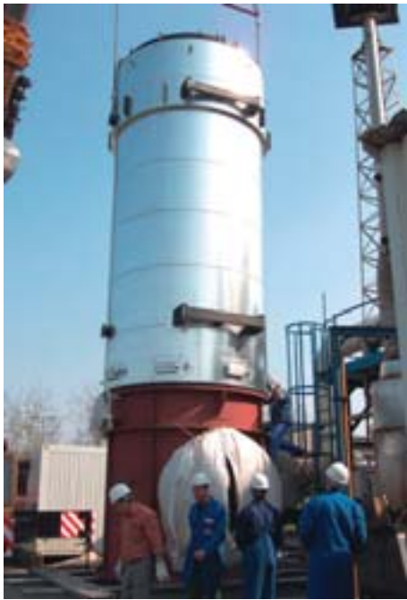
Abb. 2 Millimetergenaues Aufsetzen des Dreizugerhitzers auf die als Umlenkgehäuse ausgeführte Nachbrennkammer mit bereits installierter Ausmauerung
