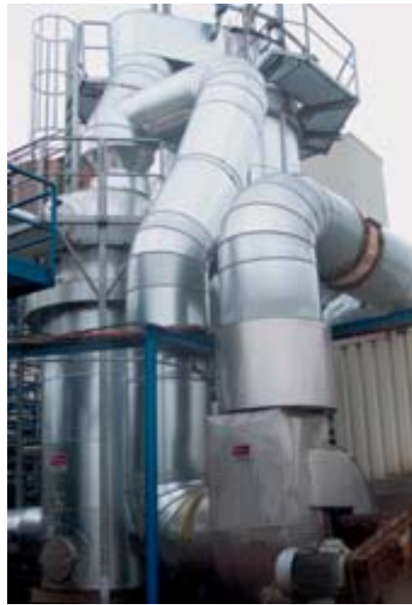
Abb. 3 Fertige, in die bestehende Anlage eingebundene Erhitzer-Luvo-Kombination
