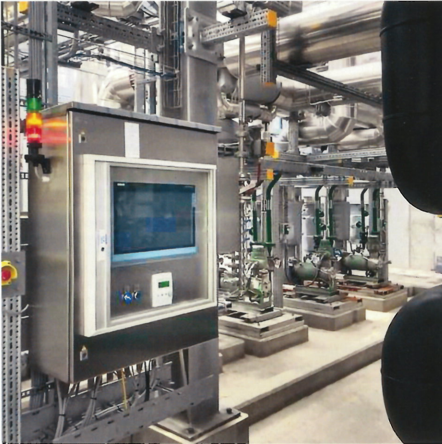
Abb. 2: In der neuen Anlage werden unter anderem auch zwei Non-Seal Spaltrohrmotorpumpen von Lewa eingesetzt. Ein Aggregat fungiert als Primärpumpe für die Zwangsdurchströmung des neu gelieferten Wärmeträgererhitzers.
