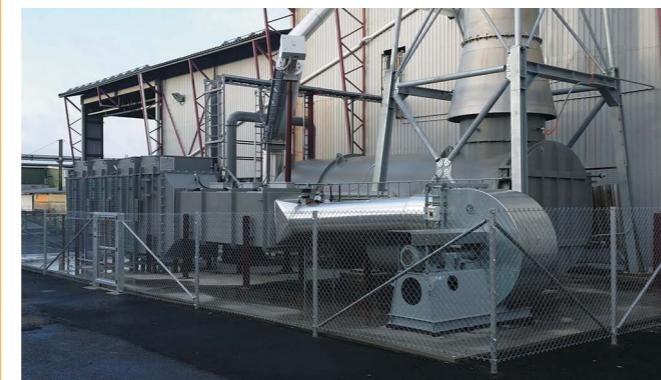
Наши надежные системы сжигания с охлаждаемыми воздухом колосниковыми решетками (мощностью от 3500 до 60 000 кВт) предназначены для использования широкого разнообразия видов биотоплива с точки зрения размера и физической влажности, при этом с превосходным дожигом и с минимальными выбросами в окружающую среду.
