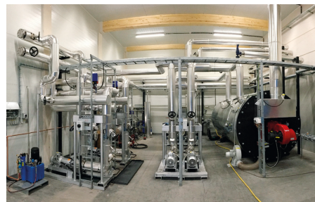
Типичный термомасляный нагреватель/термоокислитель CAW и масляные насосы для установки термической модификации древесины Jartek
