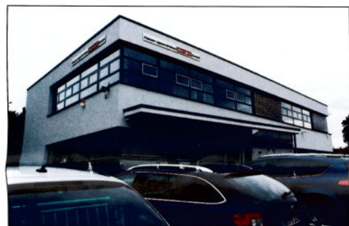
Офис Classen Apparatebau Wiesloch
